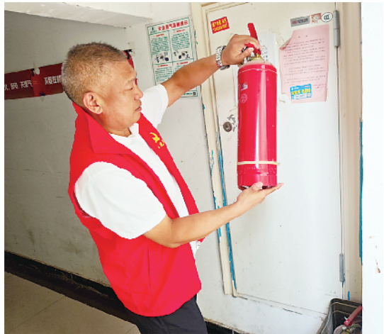
张卫华检查小区楼道灭火器。
