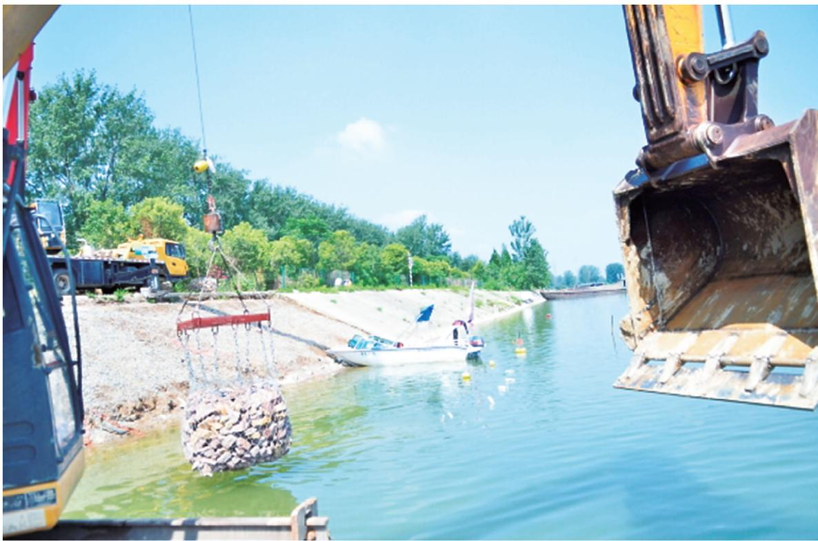
近日,我市对沙颍河周口大闸上游南岸300米处岸坡进行修复。据施工人员介绍,施工护坡面积近2000平方米,沉入水面钢筋石笼700立方米,预计7月底完工。因坡道铺有砂石,容易滑倒,水下的钢筋石笼也容易划伤身体,特提醒市民,在施工期间远离该区域。
