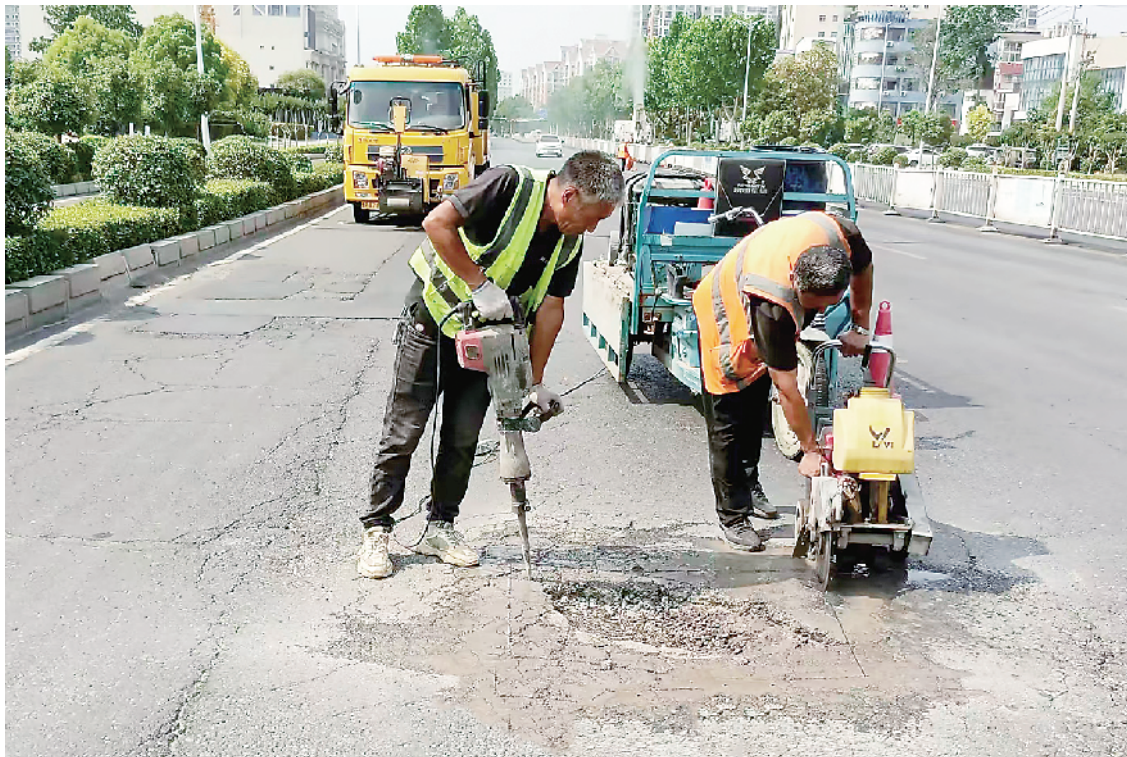
施工人员修复坑洞路面。
