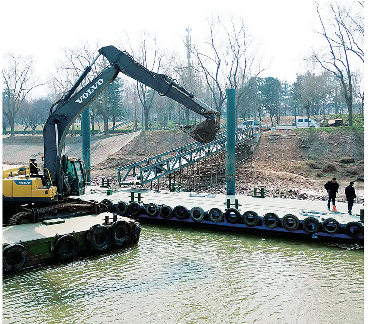
3月7日上午，在中心城区八一大道桥东侧的沙颍河南岸，施工人员正在建设岸基浮动码头。该码头建在一艘趸船上，可以随河水涨落升降，供沙颍河应急搜救指挥艇使用。
