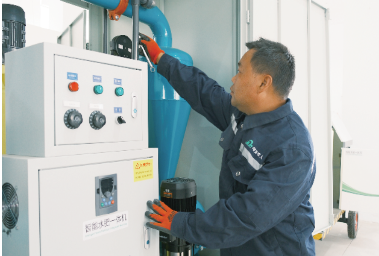
河南农人灌溉设备有限公司工作人员检修水肥一体机。
