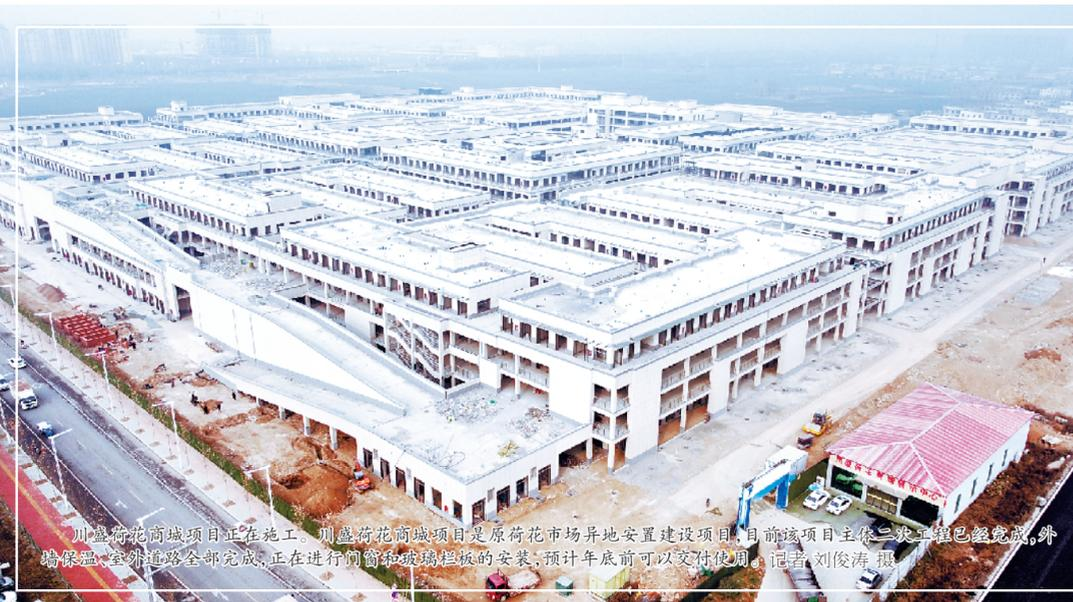
川盛荷花商城项目正在施工。川盛荷花商城项目是原荷花市场异地安置建设项目,目前该项目主体二次工程已经完成,外网保温、室外道路全部完成,正在进行门窗和玻璃幕墙的安装,预计年底前可以交付使用。记者 刘俊涛 摄
